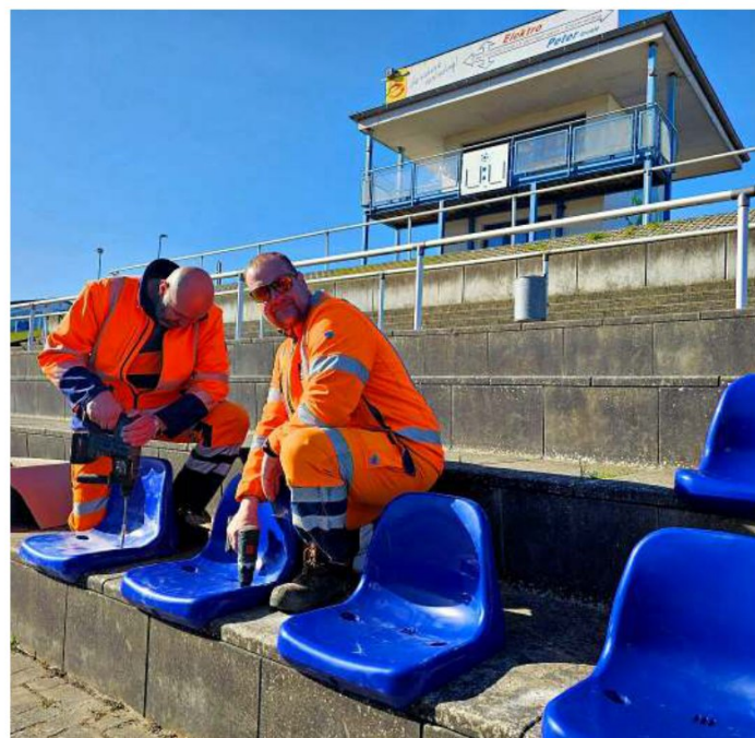
Die Männer vom Anklamer Bauhof sind mit der Montage der neuen Stadion-Sitze betraut. FOTO: ANNE-MARIE PANKRATZ
