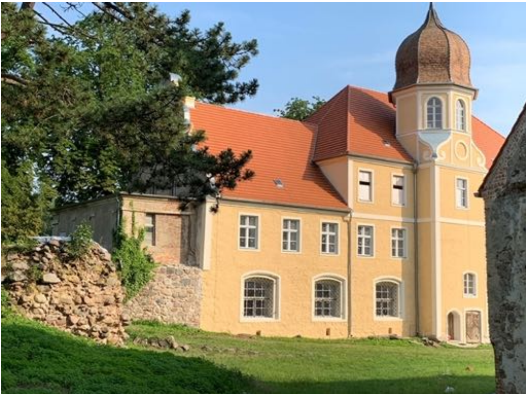
Burggebäude mit renovierter erster Hälfte der Außenfassade (August 2021)
