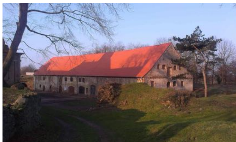
Wirtschaftsgebäude mit neuer Dachanlage
