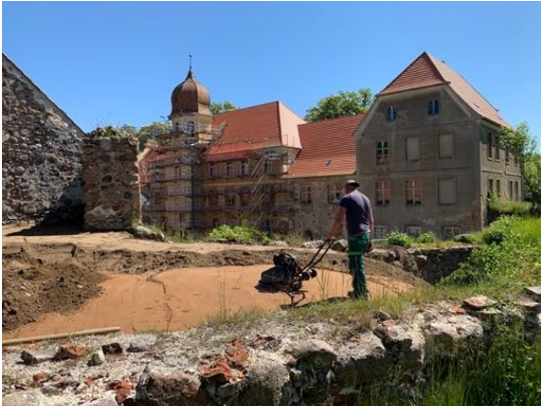
Sicherung der einsturzgefährdeten, historischen Burgtor-Anlage durch Entfernen des alten, wasserdurchlässigen Abdeckungsmaterials, Blauton und Erde, durch totale Neuabdeckung mit dem Baumaterial Dernaton, September 2021.
