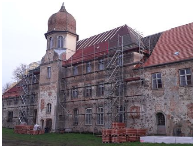
Abdeckung Hofseite mit Ziegeln (Phase II) (Stand: Dezember 2019)
