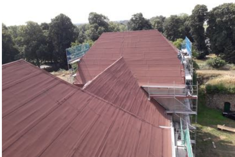
Dach Burggebäude mit Bitumenabdeckung (Stand: August 2018)
