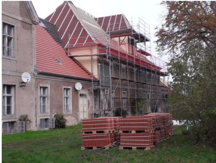
Abdeckung Wallseite mit Ziegeln (Phase II) (Stand: November 2019)
