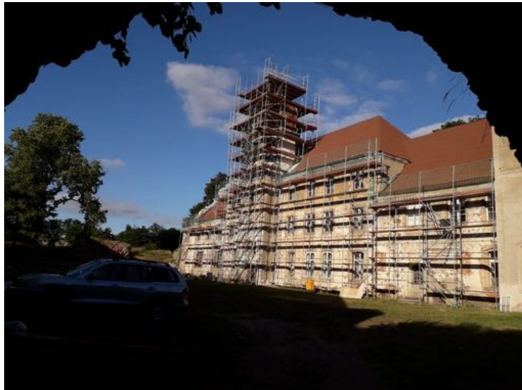
Burggebäude unter Gerüst (Stand: August 2018)
