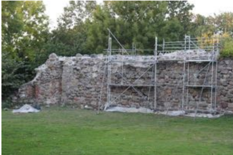
Ringburgmauer, Erste Restaurierungsphase
