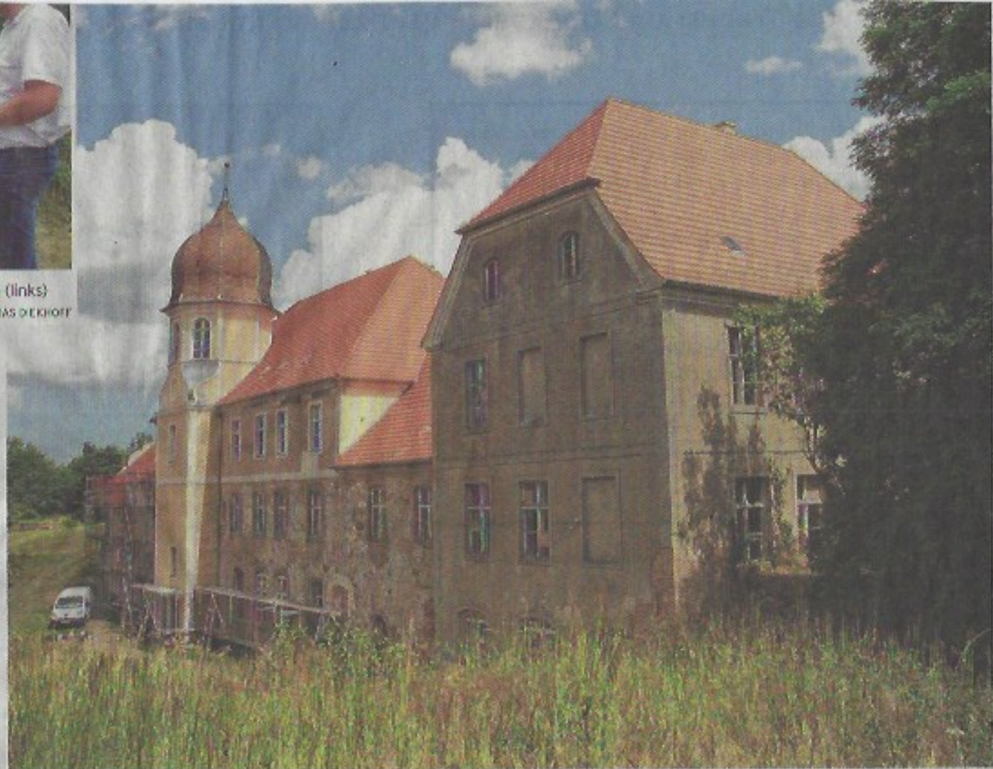
Das Dach des Hauptgebäudes der Burg Spantekow ist neu gedeckt und auch ein Teil der Fassade wurde bereits gemacht.
